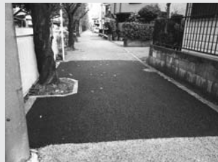
5ヶ所で道路修繕（北町5丁目用水桜並木）
