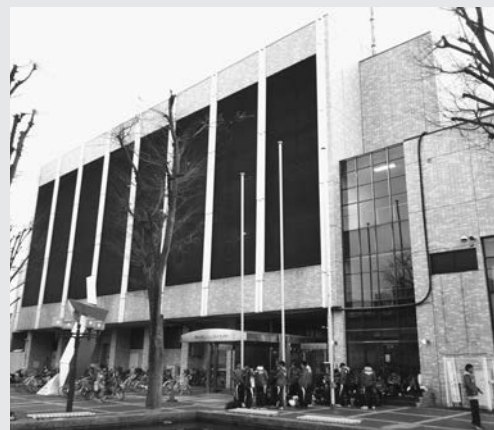
耐震化工事が行われる市民体育館
