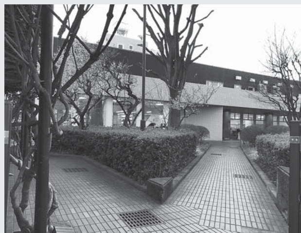
耐震補強工事が行われる図書館
