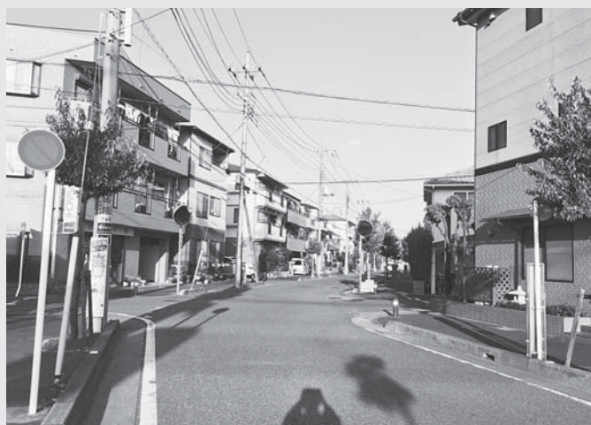
住民要望により舗装補修工事が行われる市道（郷南公園前）
